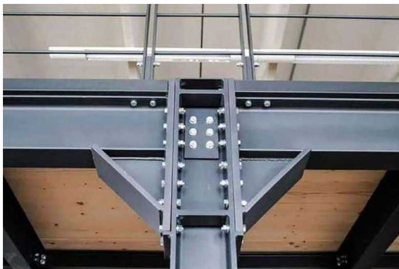
Рис. 1. Типовой фланцевый узел типа «колонна-ригель»
