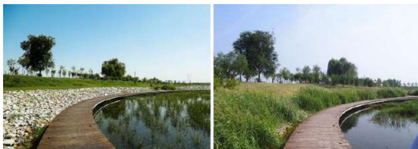
Рис. 3. Используемые биоинженерные технологии: ивовые матрасы, каменная наброска, посадка злаковых (автор фотографии: Юэянь Джинь)
